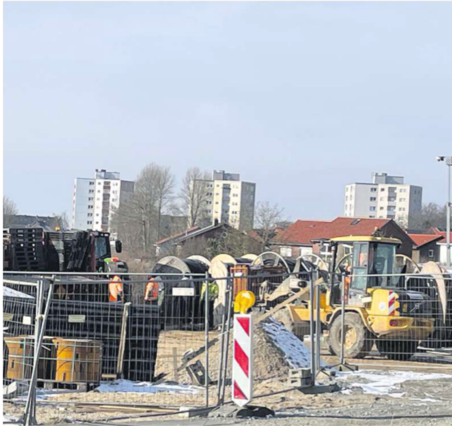
Die Arbeiten am Baugebiet im B-Plan 50 in Flintbek laufen auf Hochtouren.
